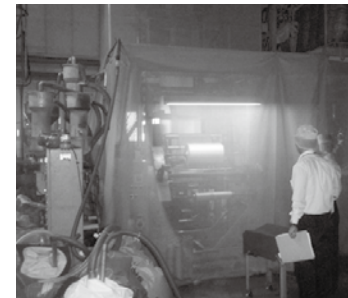
機械を覆うネットを設置
